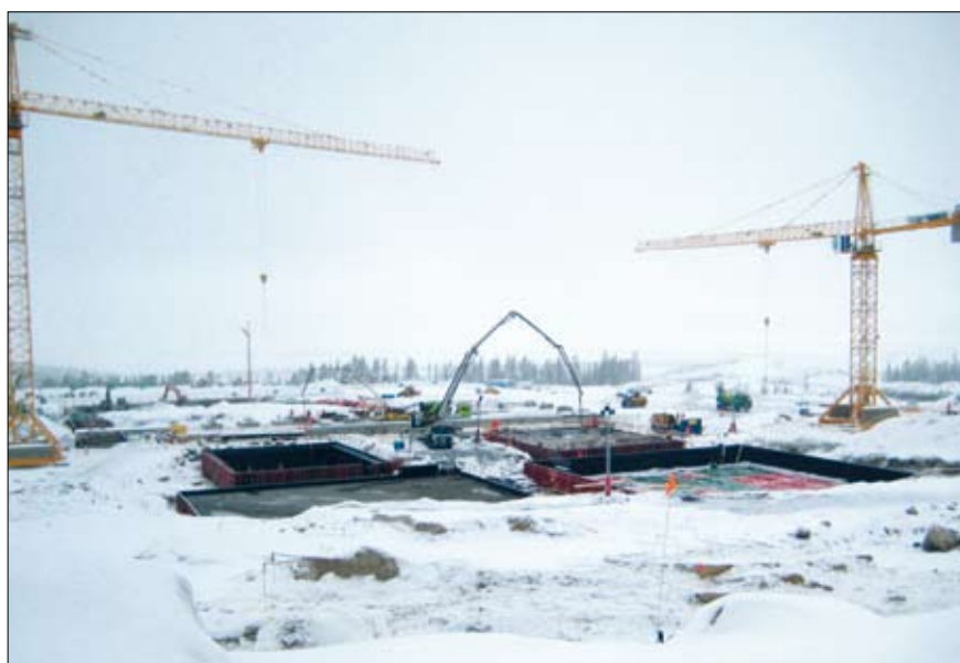
Bygget av de nya anläggningarna i Aitik är i full gång.
