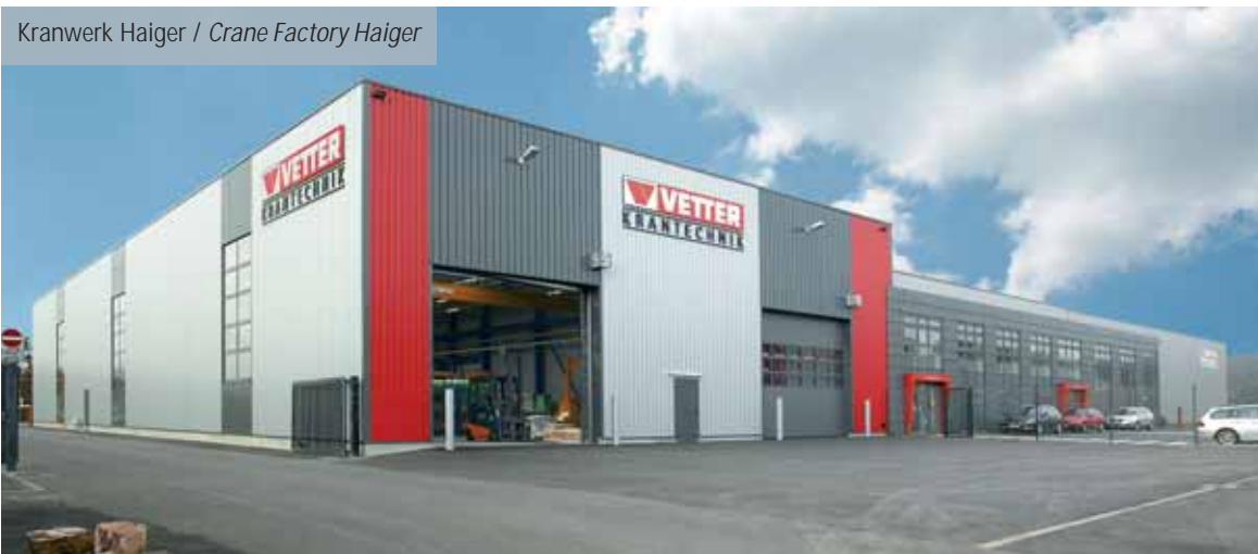
Gabelzinkenwerk Burbach / Fork Factory Burbach
