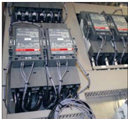
DTC gör många ombyggnationer av el.
