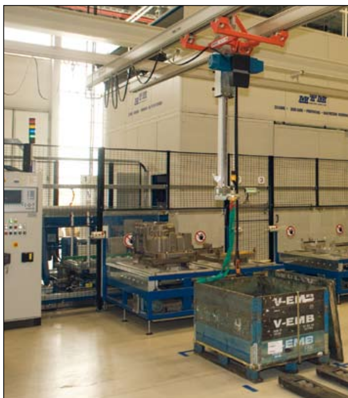
Lösningen till tvättstationen bestod av två pelarlyft upphängda i ett KBK aluline traverssystem.
