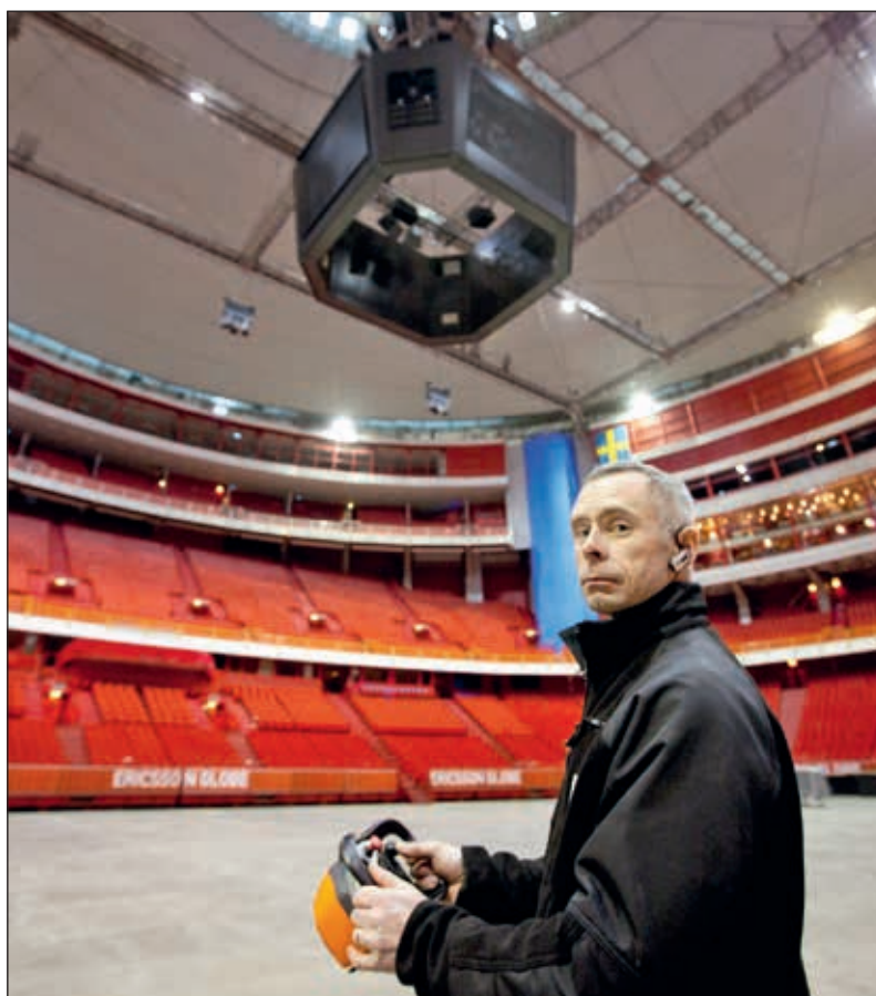
Pedro Roberto, evenemangstekniker på SGA Fastigheter, kan enkelt sänka och höja Jumbotronen med hjälp av lintelfrar och radiostyrning.
