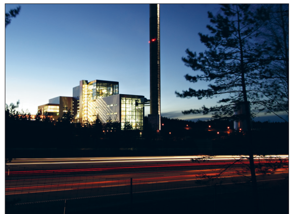
Kraftvärmeverket Torsvik är en imponerande anläggning.
