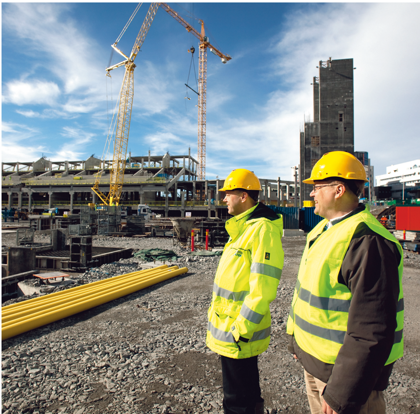
Byggnationen av Stockholmsarenan är i full gång. Invigningen är planerad till februari 2013
