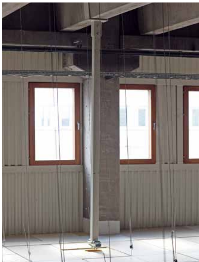
En stålkonstruktion att montera traversen i tillverkades av Dematek i Strängnäs. Stålkonstruktionen fästes ovan undertaket.
