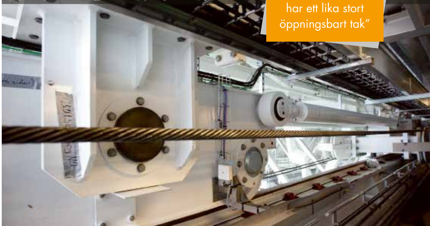
I förgrunden syns en av de 32 boggier med vars hjälp taksegmenten rullar på rälsen
