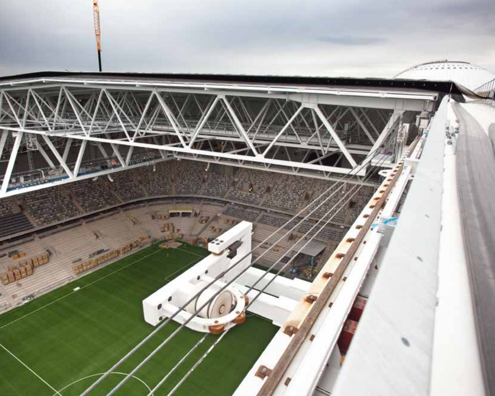
På bilden syns rälsen som taksegmenten åker på. I bakgrunden skymtar toppen på Ericsson Globe.
