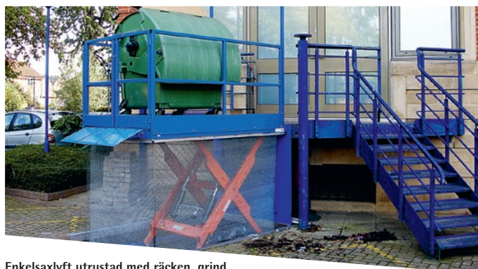
Enkelsaxlyft utrustad med räcken, grind, lastklaff och skyddsnet
