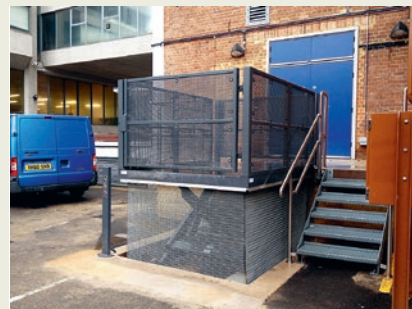
Kajlyftbord moterat i grop, utrustat med räcken och grindar samt skyddsnet.
