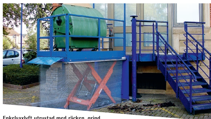
Enkelsaxlyft utrustad med räcken, grind, lastklaff och skyddsnet
