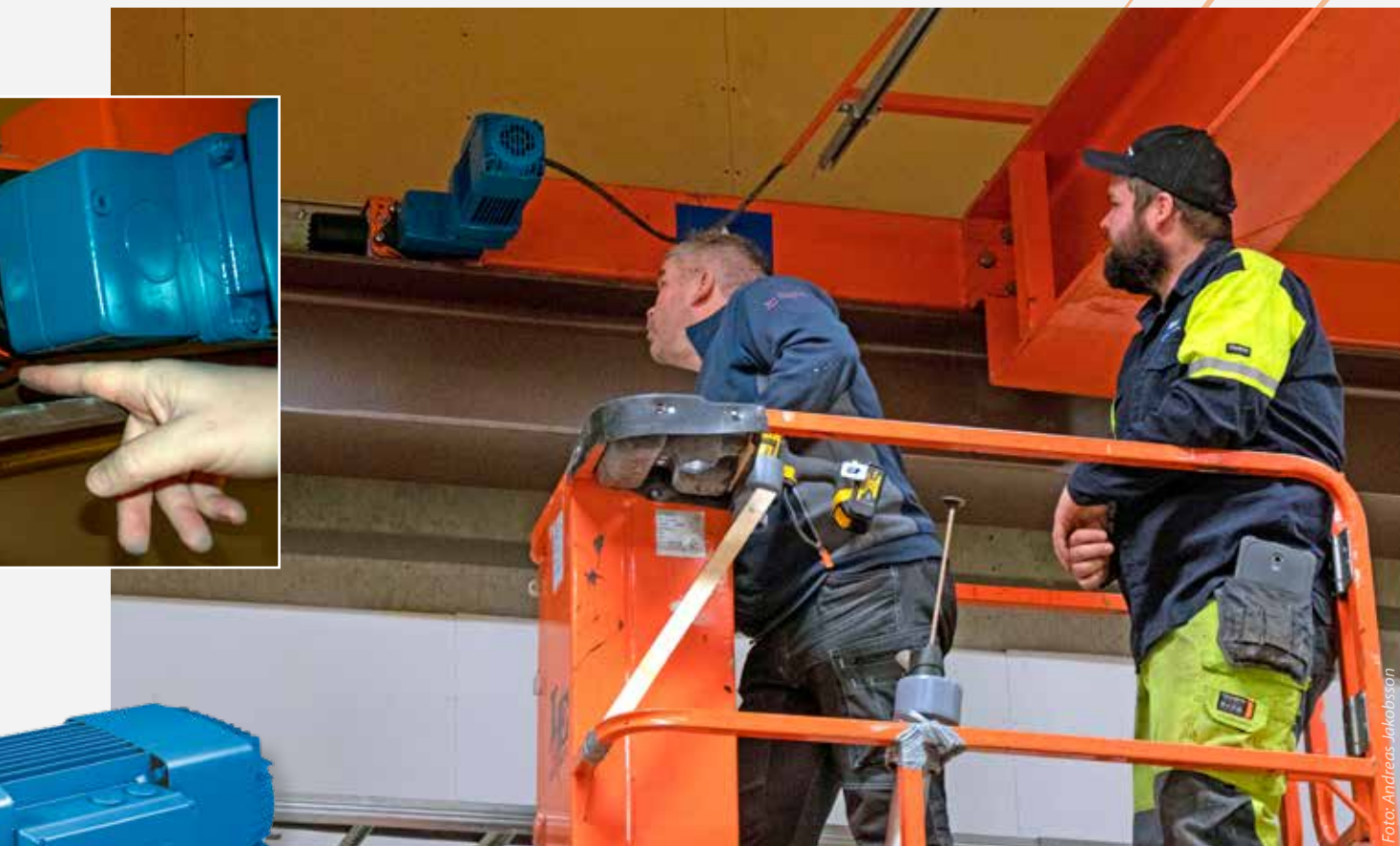
Göran Forsgren, Maxmoduler och Björn Burlin, Dematek inspekterar de nya delarna på traversen.
