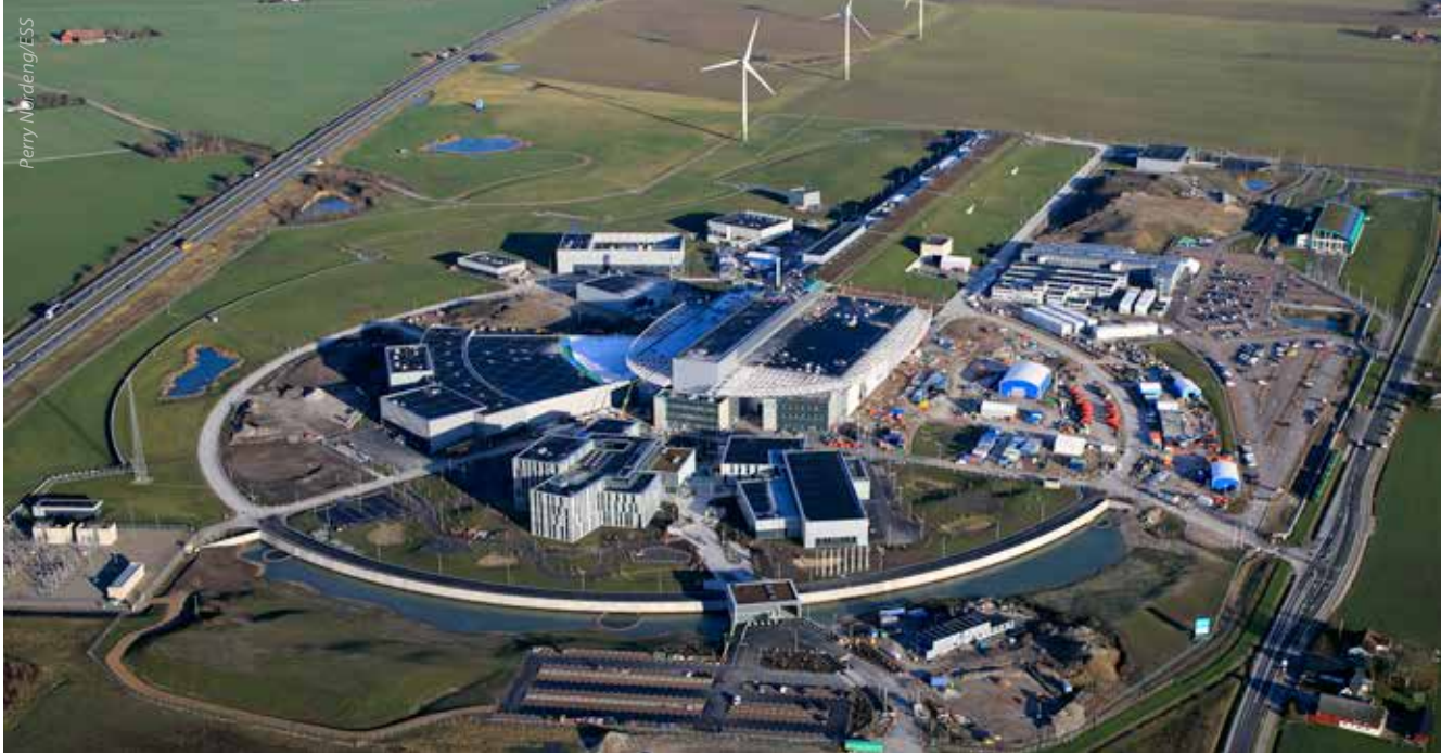
European Spallation Source (ESS) kommer bli en av världens största forskningsinfrastrukturer. Huvudbyggnadens totala längd är 700 meter och forskningsanläggningens totala byggyta motsvarar drygt 13 fotbollsplaner.
